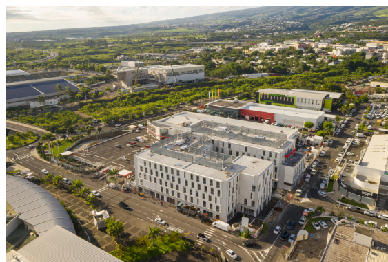
Livraison de l'opération Cour Kerveguen
